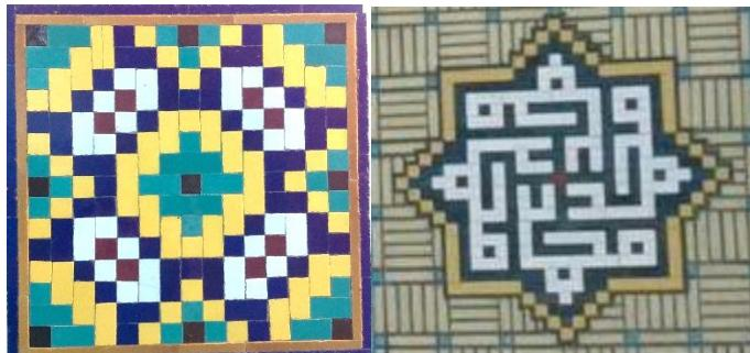
اجرای کاشی با برش های کوچک و مستقیم و از قراردادن قطعات کوچک در کنار هم تولید می شود. از جمله می توان به اجرای انواع خط بنایی و کوفی نیز اشاره نمود.
